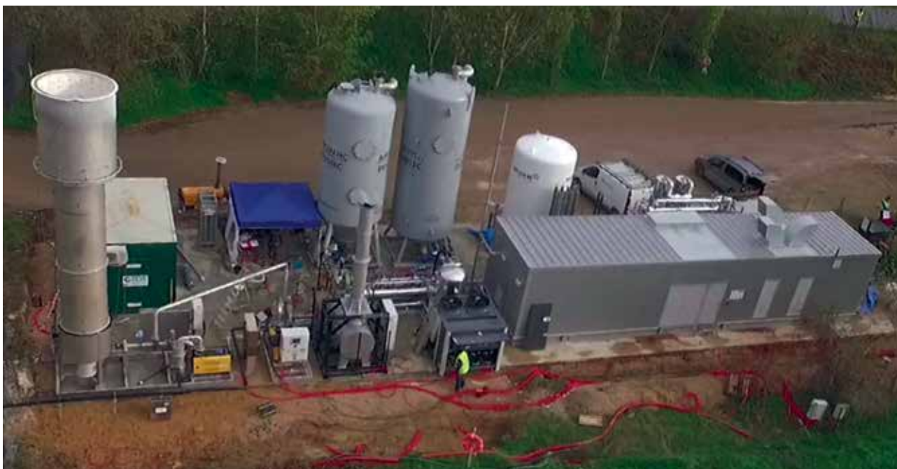
La WAGABOX 1 est la première unité d'épuration capable de produire du biométhane à partir du biogaz des déchets enfouis
