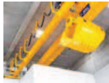
Le grappin du silo semi-enterré
